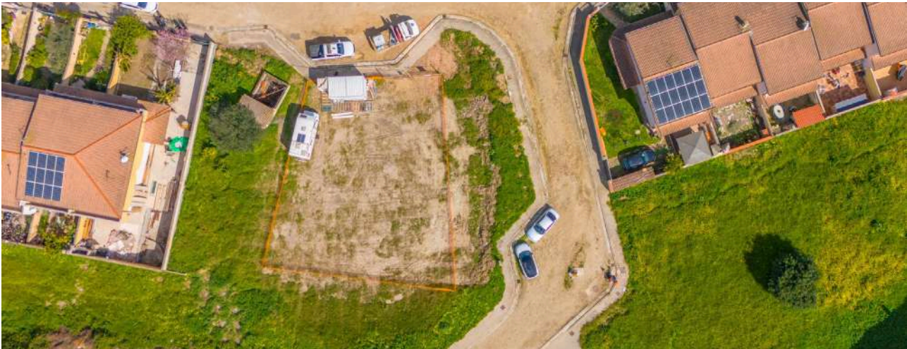
Vista zenitale di un cantiere di urbanizzazione comunale · 2026
